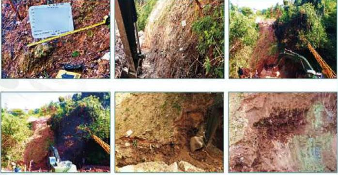
**19 de Oct. de 2021**, la continuidad de la excavación el fondo de la barranca el sedimento extraído fue mucho mas de lo esperado, por lo que se tuvo la necesidad de realizar una rampa para que el camión de volteo ingresara al área de prospección con la finalidad de despejar el exceso de material resultado de la excavación a profundidad.
