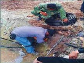
3 diciembre 2020, durante los trabajos realizados en el día dos de búsqueda, se llegaron a cortar de manera accidental dos mangueras mismas que se ocupan para la toma de agua de consumo humano, estando presente el dueño de dicha toma de agua, se le compraron dos rollos de manguera, abrazaderas y niples, mismos desperfectos accidentales fueron reparados en su momento, quedando conforme el dueño y el Comisario del poblado de Carrizalillo.
