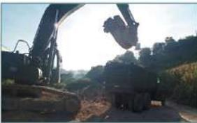
Se observa a excavadora con orugas llenando camión de volteo durante la extracción de sedimento en área de excavación.
