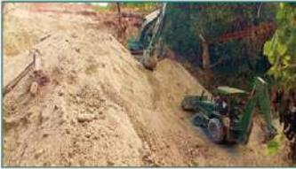
**28 de octubre de 2021**, el establecimiento de una rampa para acelerar la extracción de sedimento era fundamental por lo que la maquinaria pesada se daba a la tarea de terminar mencionada rampa la cual se confeccionaba de manera exitosa, en tanto la excavadora extraía sedimento apoyando para tal fin.
