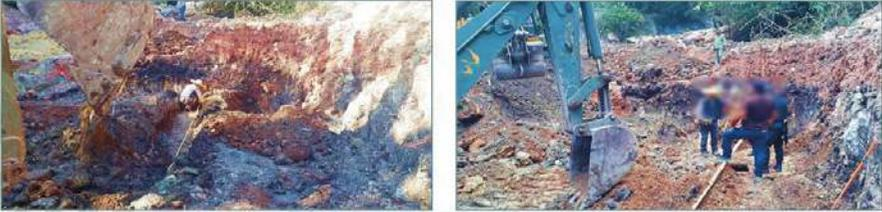
□ Durante la excavación se encontró un tubo que conecta a la cisterna. Por la remoción de tierra, mencionada conexión se aflojó en la tuerca de conexión, misma que de manera inmediata fue conectada nuevamente, el comisario mencionó que, nunca funcionó esa cisterna. Sin embargo, se dio inmediata reparación a el tubo en mención.
