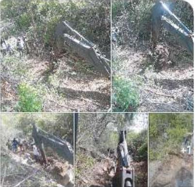
Excavación realizadas en área intervenida. Se observa la realización una cala, mediante el empleo de mano de obra así como de maquinaria pesada
