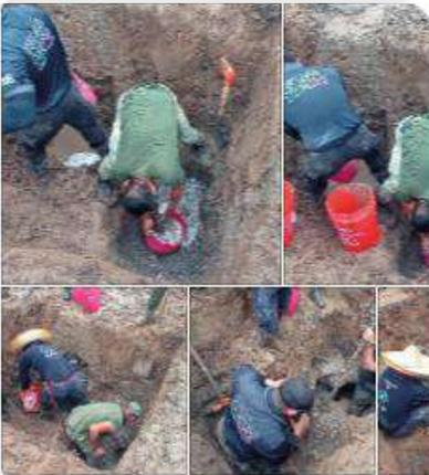
Precencia de agua en excavación iniciando a partir de 1.30 mts de profundidad.
