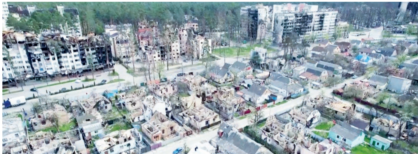
Destrucción en Irpin.
