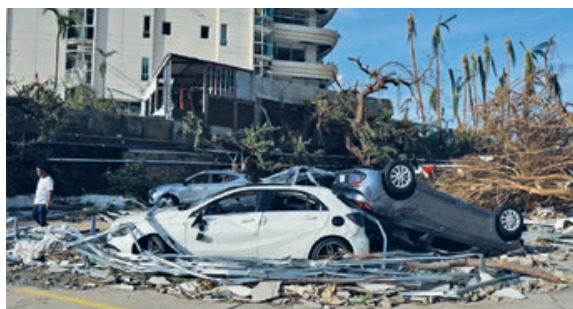
El huracán Otis destruyó Acapulco y marcó un referente para los estudiosos del tema.
